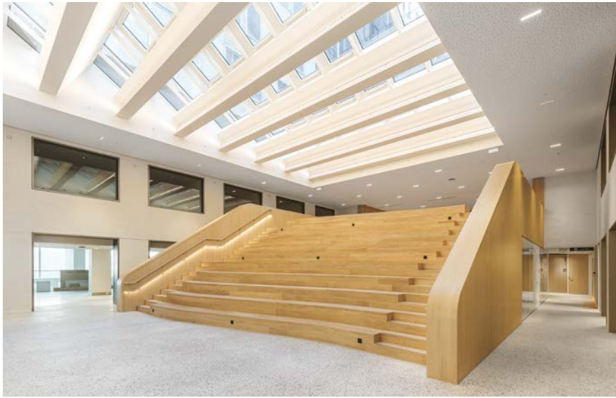
L'intervention-clé est la couverture du patio existant au moyen d'une verrière en shed pour créer une agora en double hauteur.
